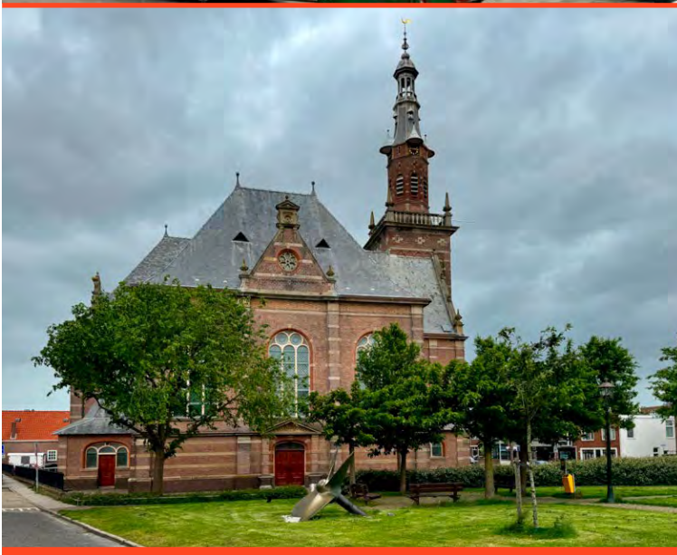
▲ Exterieur Nieuwe Kerk, Voorstraat 79 Katwijk, 1884-1887
